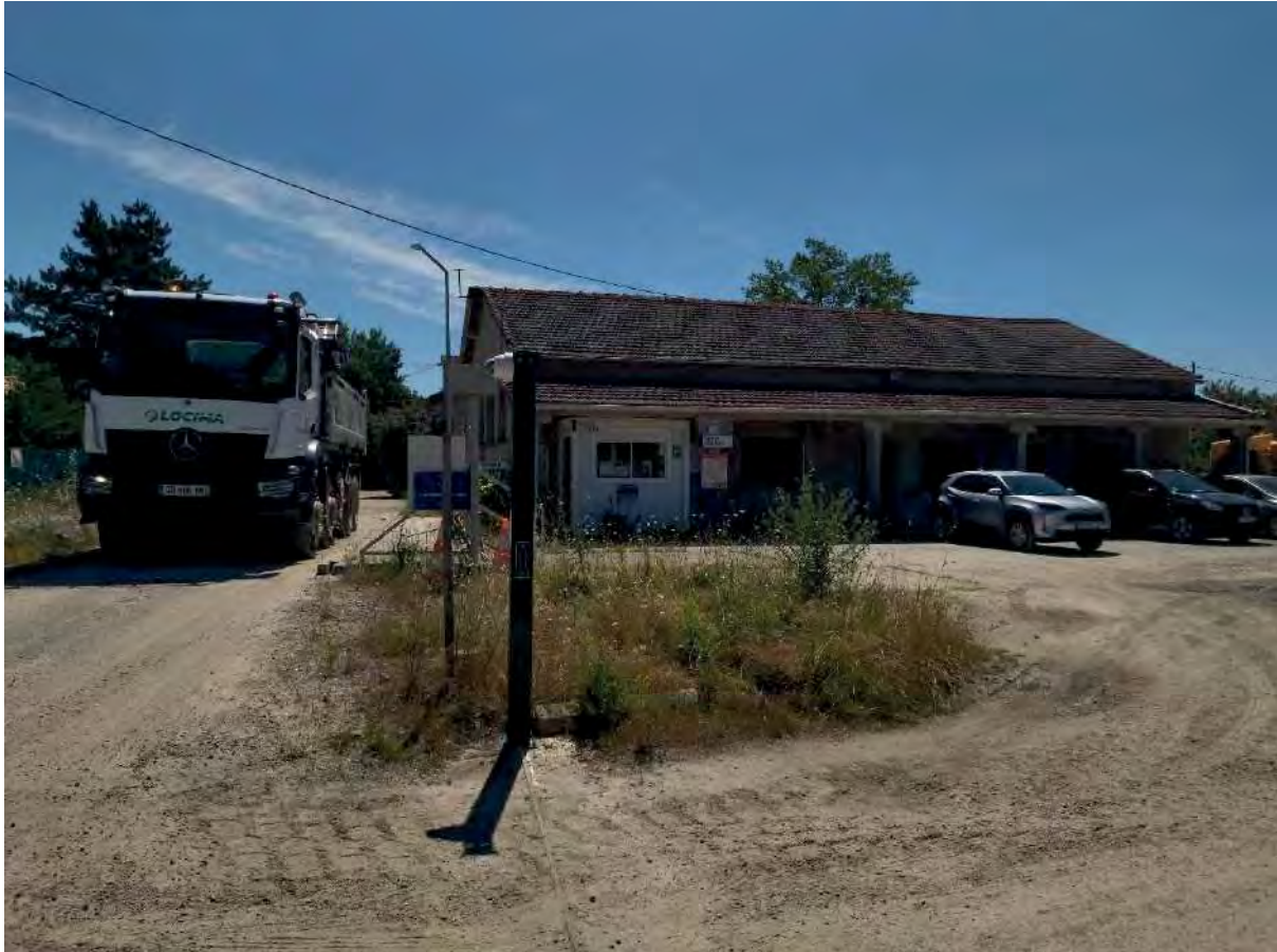
Photo 4 : Vue des bureaux et du pont-bascule
