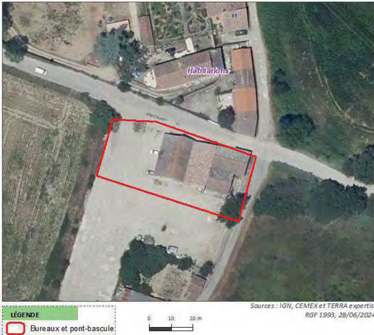
Figure 4 : Photoaérienne des bureaux
